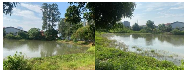
Gambar 3. Kolam retensi di Institut Teknologi PLN
