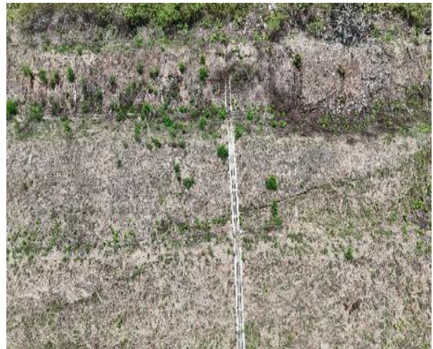
Gambar 11. Fase erosi permukaan lereng tingkat sangat lanjut di mana kestabilan lereng mulai terpengaruhi, terbentuk rekahan panjang pada badan lereng.
