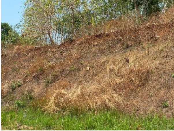
Gambar 8. Fase erosi permukaan lereng tingkat awal dengan tipe erosi lembaran ( sheet erosion )
