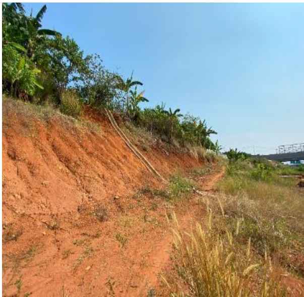
Gambar 9. Fase erosi permukaan lereng tingkat lanjut dengan tipe erosi paritan ( rill erosion ).
