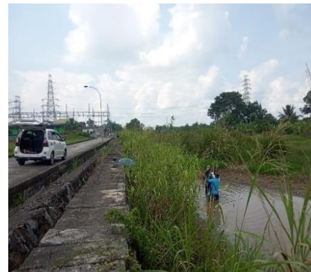
Gambar 6. Proses pengukuran resistansi pentanahan
