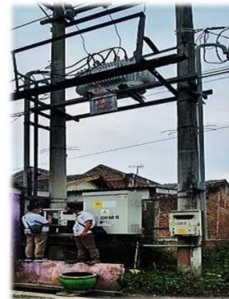
Gambar 8. Pemasangan DCU pada gardu tiang
