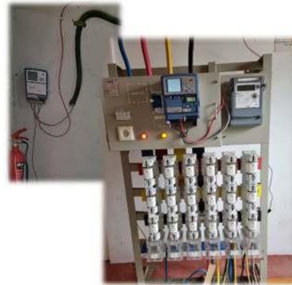
Gambar 7. Pemasangan DCU pada gardu beton
