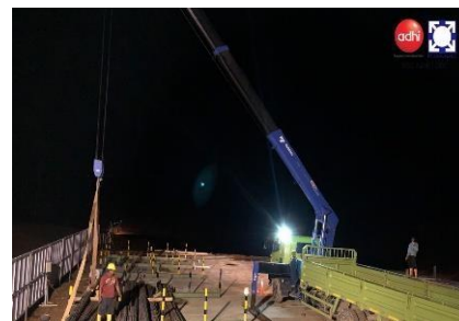
Gambar 5. Penempatan material baja tulangan
