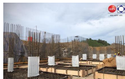
Gambar 6. Proteksi kolom sebelum pengecoran footing pada Proyek Pembangunan Rumah Tapak Jabatan Menteri di KIPP IKN
