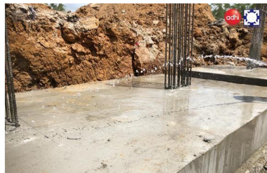
Gambar 8. Curing setelah pengecoran
