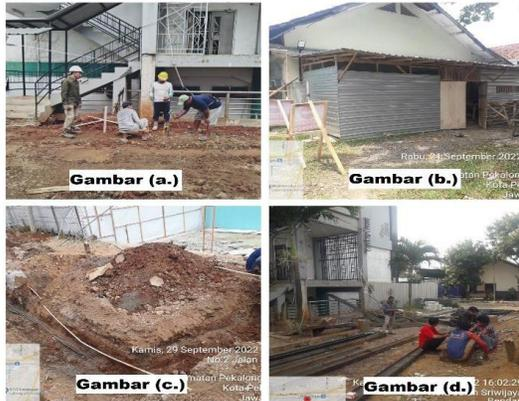
**Gambar 6.** Pekerjaan persiapan. (a) pengukuran dan pemasangan *bouwplank* (kiri-atas), (b) pembuatan direksi *keet* (kanan-atas), (c) pemindahan jaringan kabel telepon RS (kiri-bawah) (d) pembongkaran bangunan eksisting (kanan-bawah)
