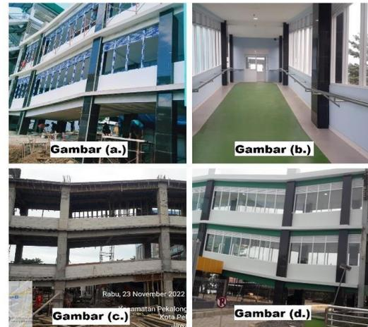
**Gambar 8.** Pekerjaan arsitektur. (a) pekerjaan kusen pintu dan jendela (kiri-atas), (b) pekerjaan *polyfloor epoxy* (kanan-atas), (c) pekerjaan pasangan dinding, plesteran dan acian (kiri-bawah), (d) foto 100% pekerjaan arsitektur (kanan-bawah)
