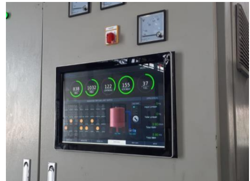
Gambar 5. Monitoring suhu ruang bakar 1 dan 2
