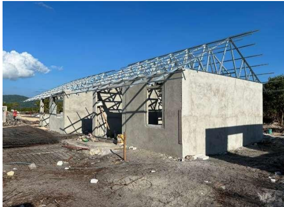
Gambar 8. Contoh pemasangan kuda-kuda rangka baja ringan
