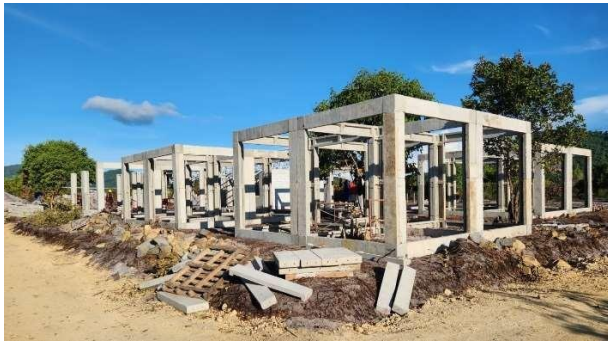
Gambar 6. Contoh peyambungan panel RISHA di Pulau Serasan
