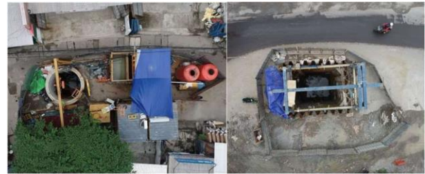
Gambar 3. Starting pit mesin XCMG (kiri), Starting pit mesin ISEKI (kanan)
