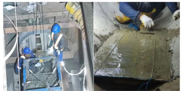
Gambar 17. Pelaksanaan pengecoran flooring dan pemasangan guide roller
