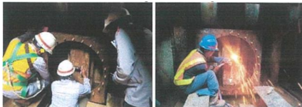
Gambar 14. Pemotongan SSP untuk entrance ring
