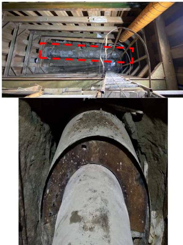
Gambar 20. Hasil pekerjaan open face jacking RCP 600 mm
