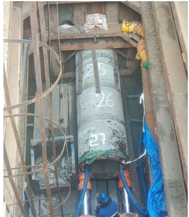
Gambar 16. Jacking casing pipe dn1000 mm paralel dengan chipping batuan
