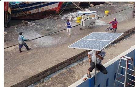
**Gambar 3.** Pemasangan tiang penyangga dan bracket modul surya
