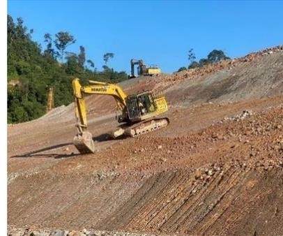
**Gambar 8.** Pemotongan dan pemadatan lereng terluar badan TSF menggunakan ekskavator
