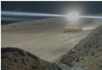
**Gambar 7.** *Compactor* tapak halus memadatkan lantai zona 3
