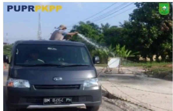
Gambar 14. Pemeliharaan beton
