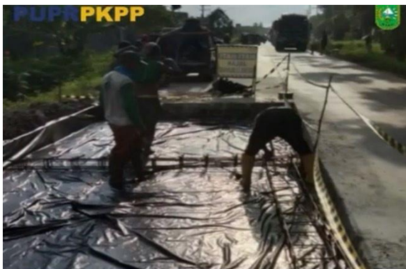
Gambar 12. Pekerjaan pembesian/penulangan
