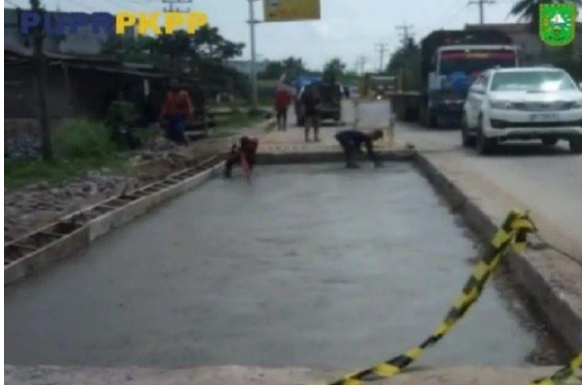
Gambar 11. Pembuatan lantai kerja
