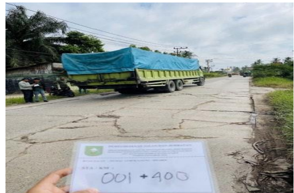
Gambar 2. Kondisi eksisting STA 1+400
