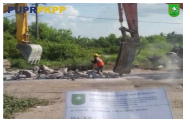
Gambar 10. Pembongkaran rigid beton lama
