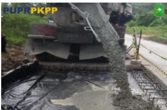
Gambar 13. Pengecoran ready mix K-350
