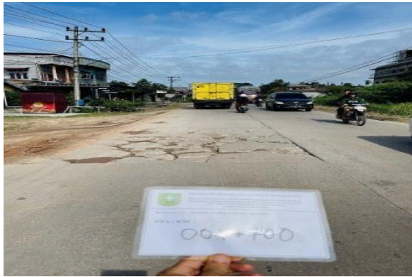
Gambar 3. Kondisi eksisting STA 1+700
