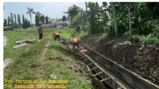
**Gambar 5. Pekerjaan Pembesian dan Bekisting U-ditch Insitu**
