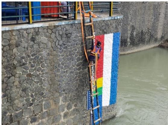
**Gambar 8.** Pengecatan marka elevasi siaga
