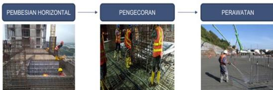
Gambar 10. Tahapan pembesian, pengecoran, dan Perawatan
