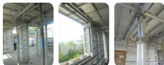
Gambar 4. Bekisting Kolom, Bukaam, dan *Leveling*
