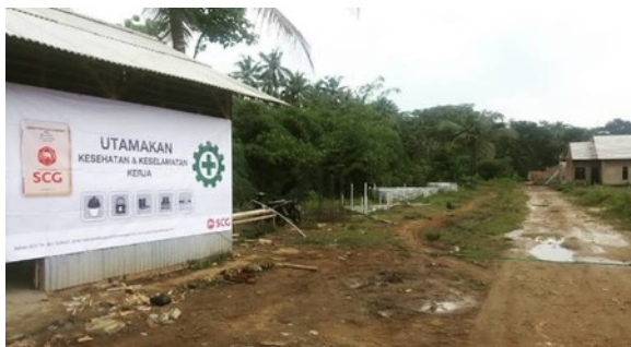
Gambar 2. Spanduk K3L di Lokasi Proyek Perumahan Pesona Estetika Cikembulan
