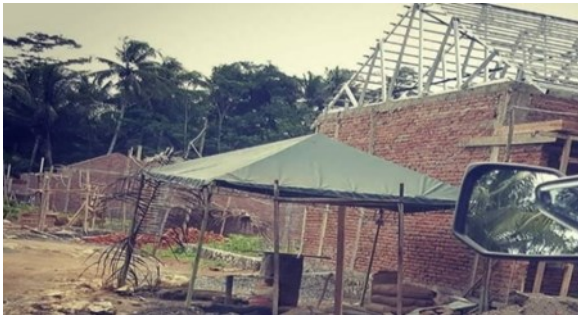
Gambar 4. Kontruksi Bangunan di Perumahan Pesona Estetika Cikembulan
