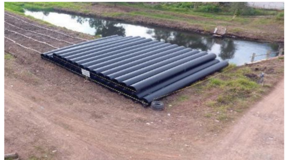
Gambar 2. Stock yard pipa di dekat saluran irigasi
