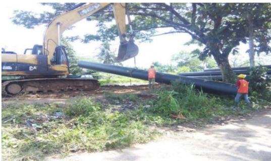
Gambar 6. Proses pengangkatan pipa HDPE
