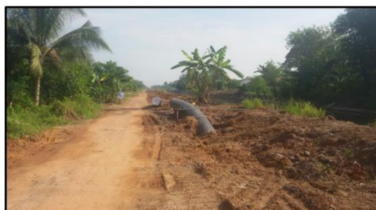
Gambar 12. Pipa yang sudah ditanam dan salah satu ujungnya diatas permukaan tanah.
