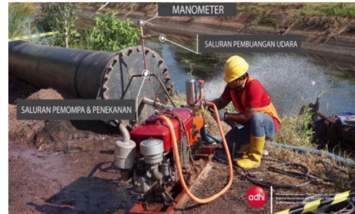
Gambar 13. Proses Pemasangan Stub End dan Accessories pada pengujian hydrotest.
