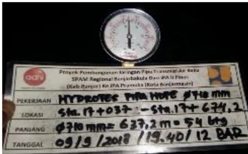
Gambar 16 Pengamatan Manometer pada pengujian Hydrottest.
