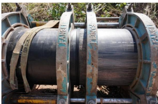
Gambar 11. Proses penyatuan kedua ujung pipa setelah dipanaskan.
