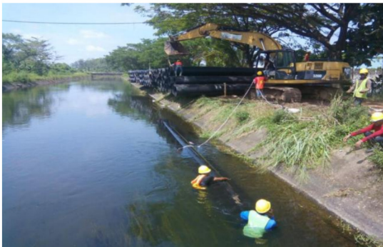
Gambar 5. Proses pengangkatan pipa HDPE
