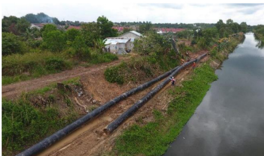
Gambar 7. Pipa HDPE diletakkan disepanjang jalur Pipa
