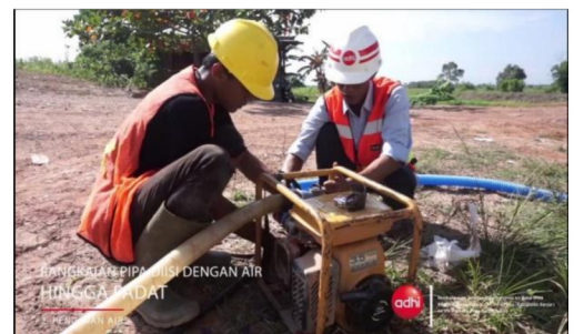
Gambar 14. Proses pengisian air pada rangkaian pipa.
