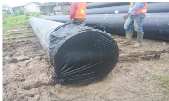
Gambar 4. Proses penutupan kedua ujung pipa HDPE sebelum dihanyutkan.
