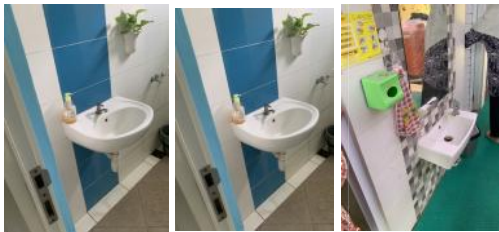
Gambar 1. Kondisi kamar mandi dan toilet.
