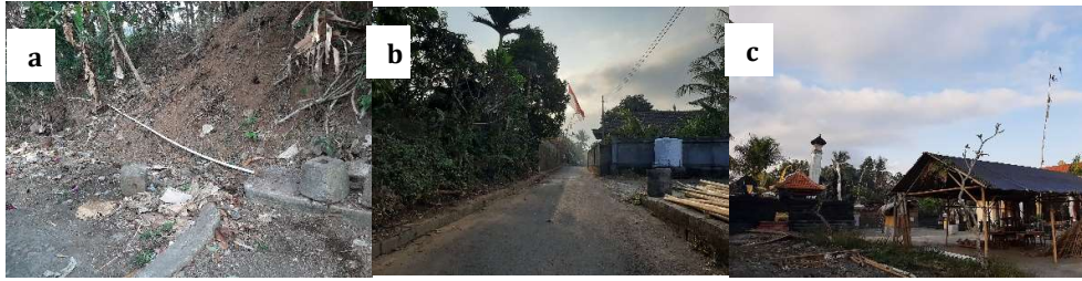
Gambar 4. (a) (b) (c) Pemasangan Pipa di Mata Air, (a) di Sepanjang Jalan Curam, (b) Jalan Menuju Desa, (c) Jalan ke Pusat Pengisian Ulang
