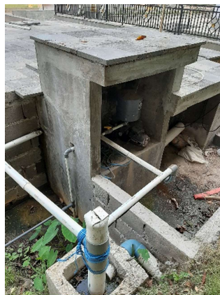
Gambar 3. Panel dan Pompa di Taman Beji Paluh Gambar 3 menjelaskan proses pemasangan pompa submersible di tangki mata air di Taman Beji Paluh.
