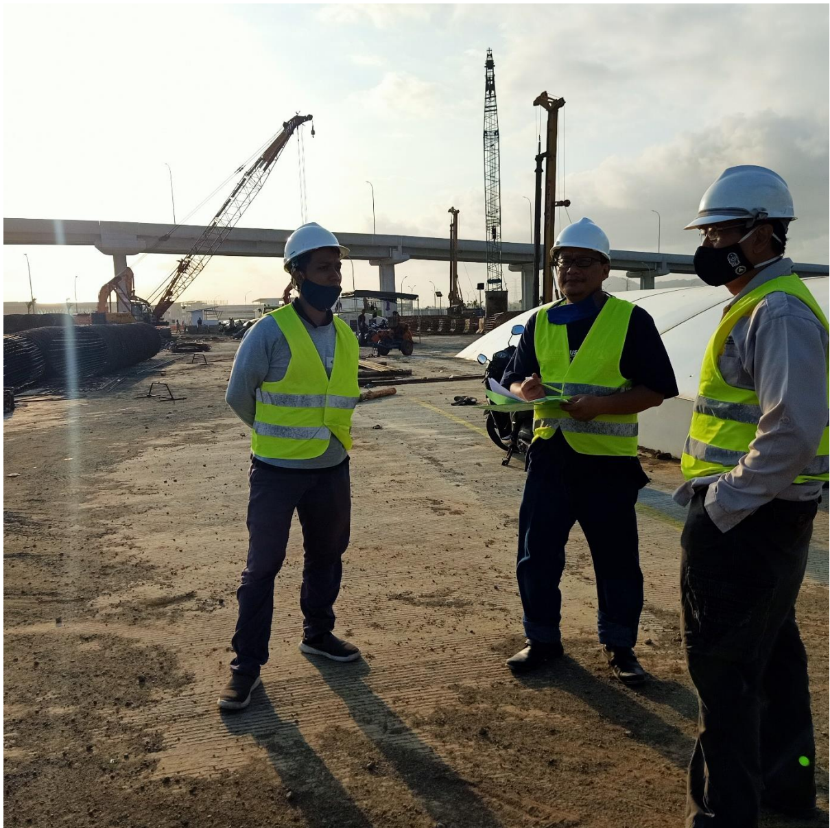
Diskusi Kondisi di lokasi pembangunan NYIA
