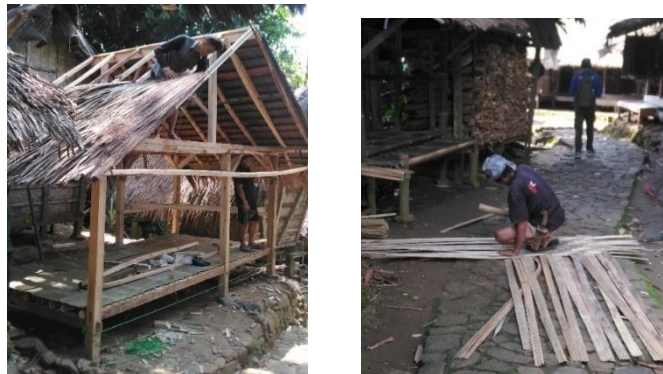
Gambar 2. 5 Proses pembangunan rumah
