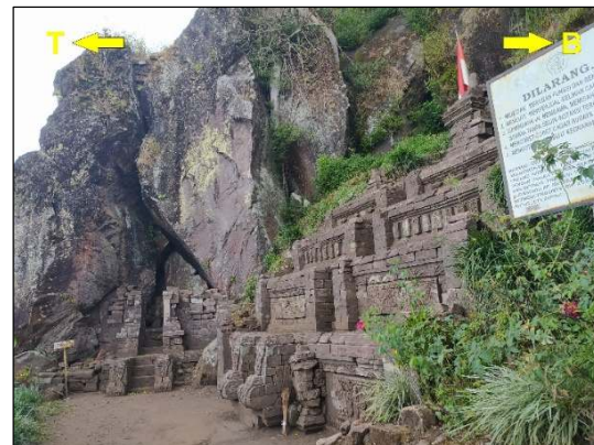
Gambar 11. Kenampakan geosite Candi Kendalisodo dengan struktur bangunan candi yang berundak sebagai aspek geologi bangunan yang menarik karena beradaptasi dengan kondisi lahan dimana geosite berdiri.
