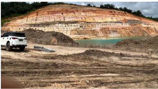
Gambar 11. Kondisi Lereng Keseluruhan
