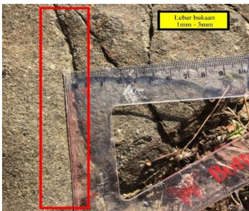
Gambar 5. Bukaan dikontinuitas, panjang diskontinuitas dan kondisi umum keairan LP1
