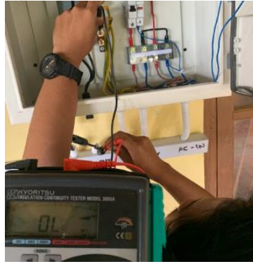
Gambar 9. Hasil Sambungan Kabel Positif dan Ground
