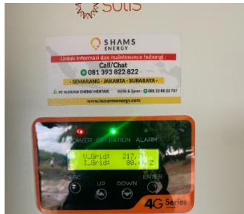
Gambar 11. Pengujian Hasil Keluaran Inverter yang Terkoneksi dengan Beban.
