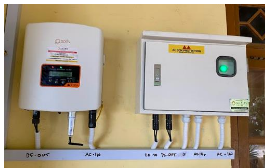
Gambar 6. Dokumentasi Inverter dan Panel Box Proteksi
