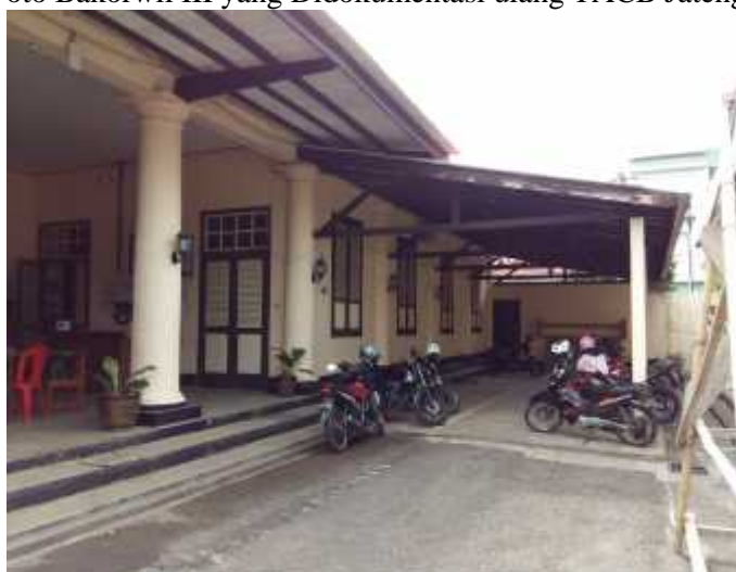
Gambar 2: Bangunan Eks Rumah Dinas Residen Banyumas dari sisi Bagian Barat Sumber: Dokumentasi TACB Jateng, Desember 2015
