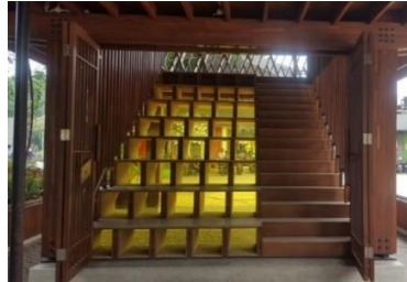
Gambar 5. Tangga dan Pintu Microlibrary Warak Kayu
